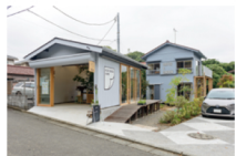
センスの良さが光る温かみのある外観
